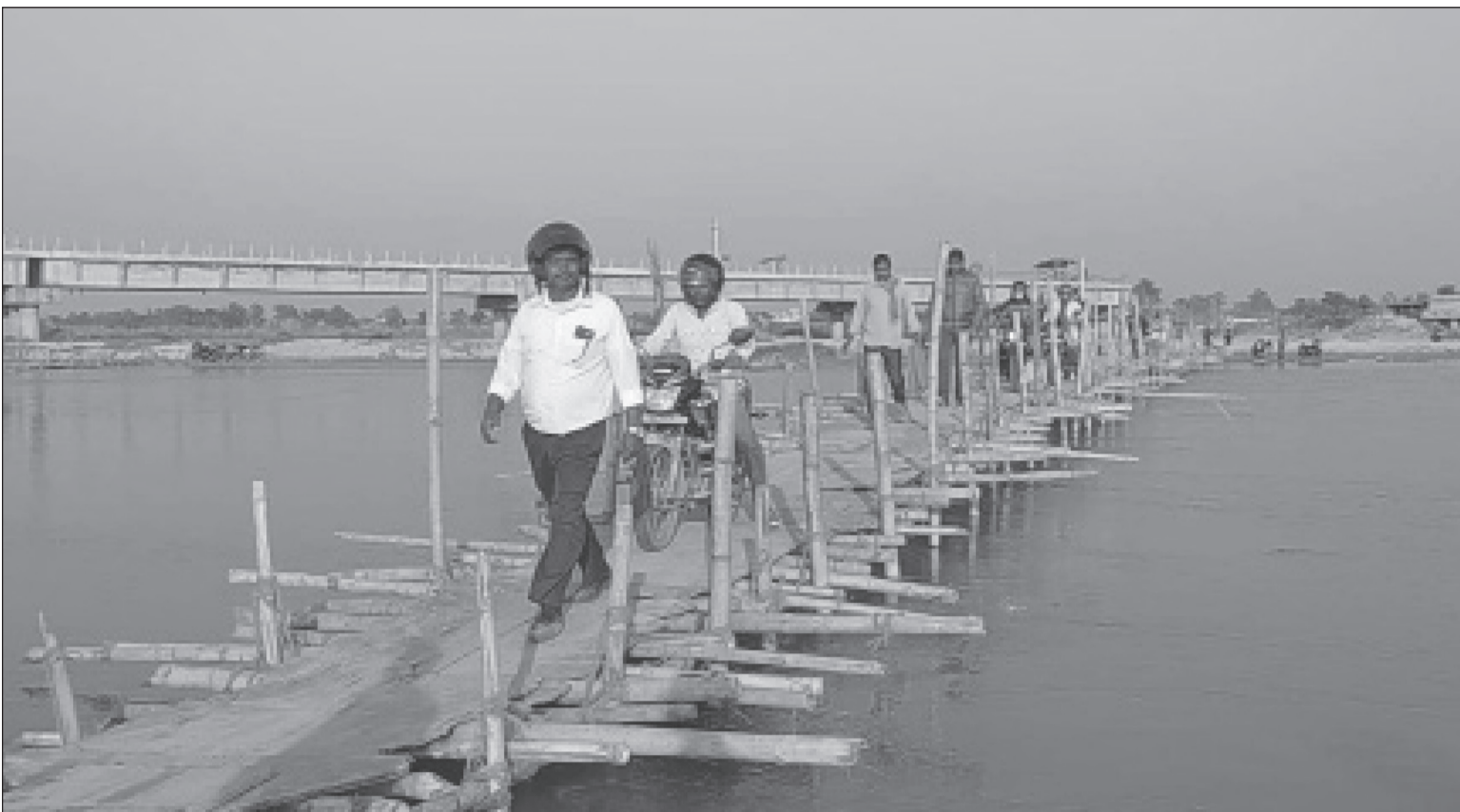
स्थानीयहरूले आफ्नो लगानीमा काठेपुल निर्माण गरेपछि धनुषा र सिरहा जोड्ने कमला नदीमा सर्वसाधारण आवतजावत गर्दै।
