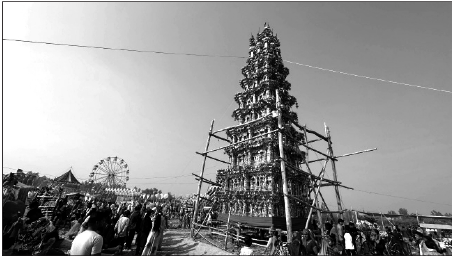
सर्लाहीको पर्सा गाउँपालिका-६ पर्सास्थित मुस्लिम धर्माबलम्बीहरूले बनाएको दाहा (ताजिया)। एकसय १० फिट अग्लो ताजिया निर्माण गर्न बाँसलगायत विभिन्न रङ्गका प्लास्टिक र कागको प्रयोग गरिएको छ। यहाँ अहिले मेला जारी छ।
