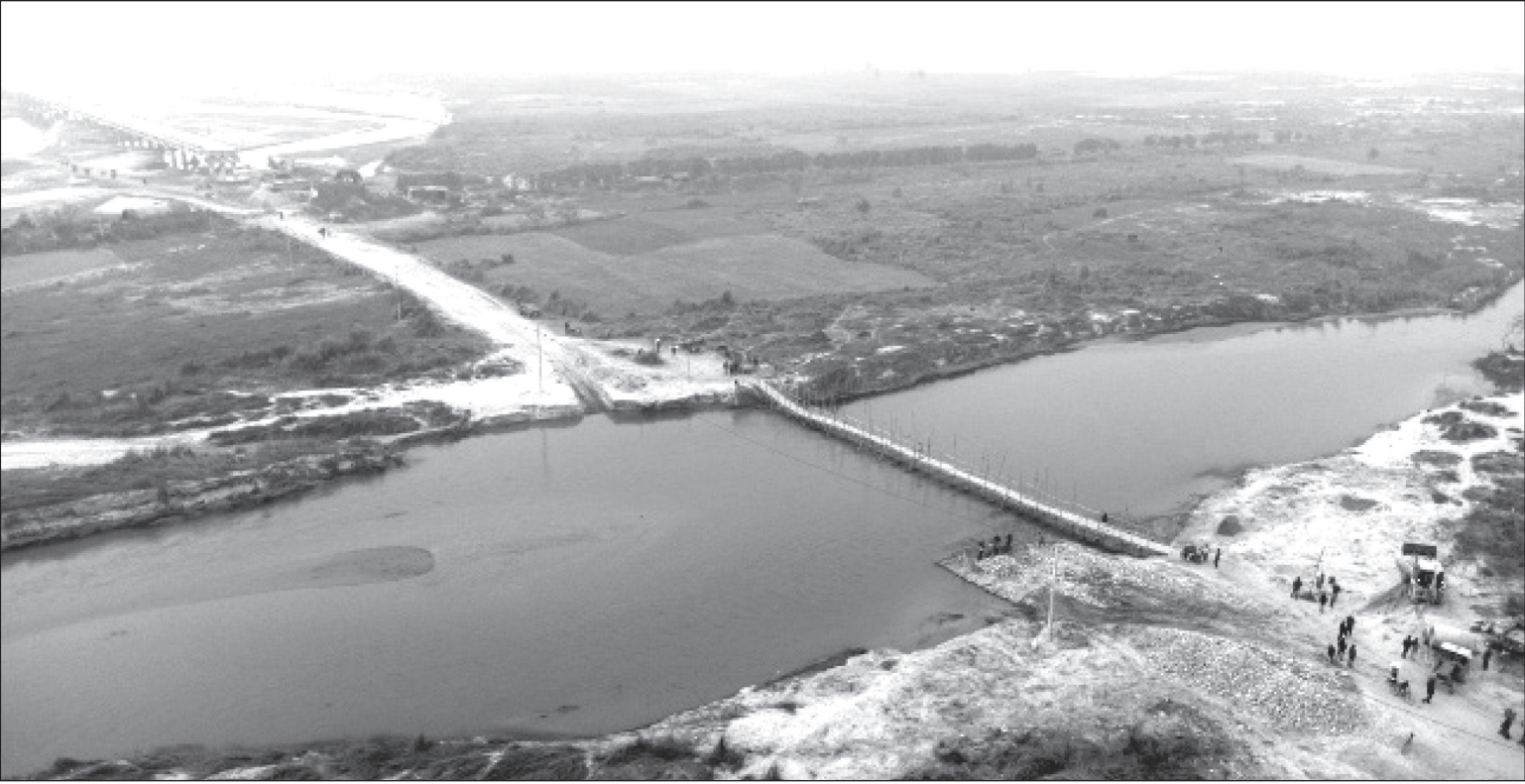
सञ्चालनमा आउनुअघि नै भौसिएर करिब १३ वर्षदेखि निर्माणाधीन रहेको धनुषा-सिरहा जोड्ने कमला पुलको पुनर्निर्माण गर्दै ठेकेदार कम्पनी पणु-लुम्बिनी जेभी। २०८३ असार मसान्तसम्म निर्माण सम्पन्न गरी सरकारलाई हस्तान्तरण गर्ने कम्पनीको तयारी छ ।
