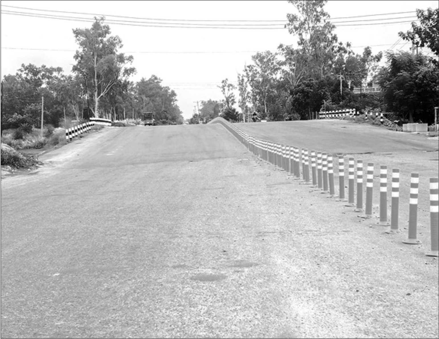
सडकको बीचमा प्लास्टिकका फ्लेक्सिबल डिभाइजर जडान : महोत्तरीको जलेश्वर नगरपालिका जिरो माइलमास्थित जनकपुर-जलेश्वर जाने सडकको बीचमा सवारी आवागमनलाई व्यवस्थित गर्न राखिएको प्लास्टिकका फ्लेक्सिबल डिभाइजर । ट्राफिक जाम र दुर्घटनाको जोखिम न्यूनीकरण गर्ने उद्देश्यले सडकमा डिभाइजर जडान गरिएको हो। तस्विर:चन्दन ठाकुर/ रासस
