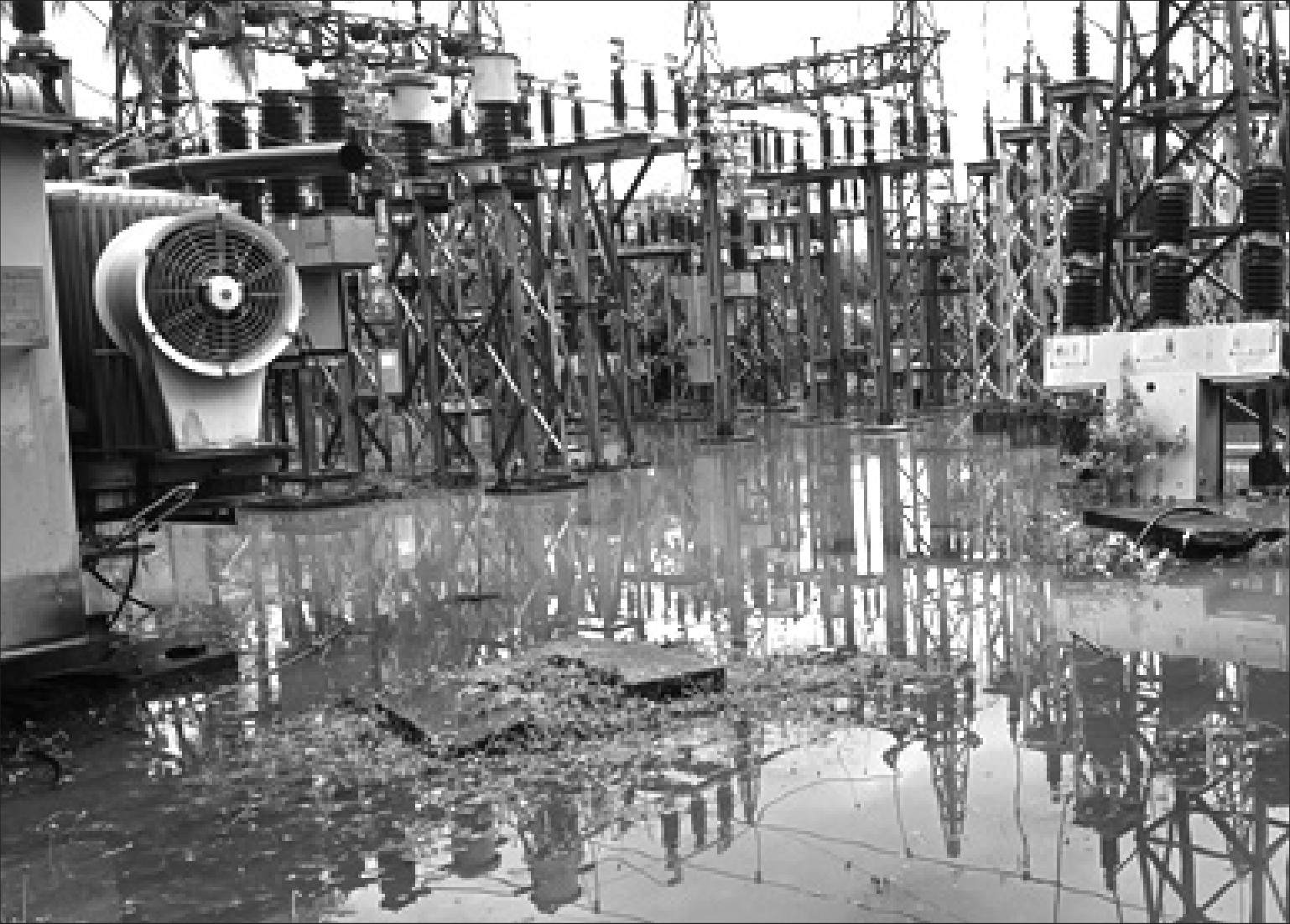
डुबानमा परेको सबस्टेशन: लगातारको वर्षापछि आइतबार डुबानमा परेको सर्लाहीको मलङ्गवा नगरपालिका-२,स्थितनेपाल विद्युत प्राधिकरण मलङ्गवा वितरण केन्द्रको सबस्टेशन। निकास नहुँदा वर्षातको पानीले सबस्टेसनको कन्ट्रोल प्यानल डुबाउँदा गए्राति देखिने यस क्षेत्रमा विद्युत अवरुद्ध भएको छ ।
